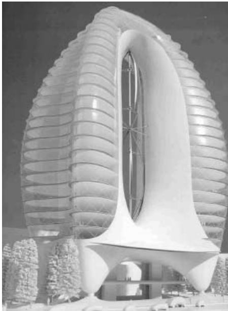
Figura 25 - Sin. Modello di Studio per Palazzo a Destinazione Terziaria con Integrazione di Generatore Eolico nella Matrice Strutturale. Dest.: Plot 3d dei Vettori di Velocità da Analisi CFD (Computational Fluid Dynamic)
