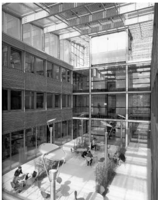
Figura 18 - Atrio Interno; in Copertura Pannelli Fotovoltaici con Funzione di Frangisole
