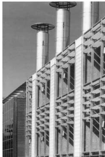
Figura 22 – Dettaglio dei frangisoli e dei camini solari
