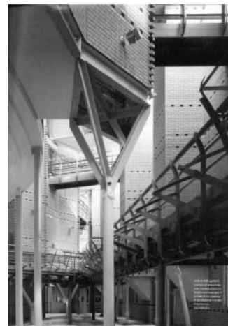
Figura 14 – Main Street, dettaglio della parte inferiore del camino di ventilazione
