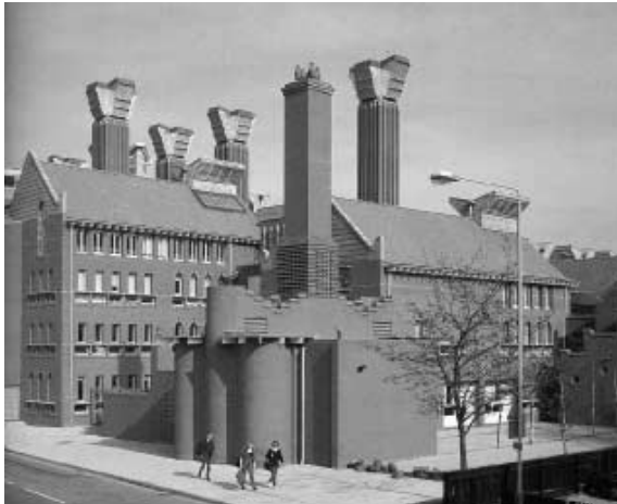
Figura 15 - Vista Esterna del Complesso, in Primo Piano il Locale Centrale Termica
