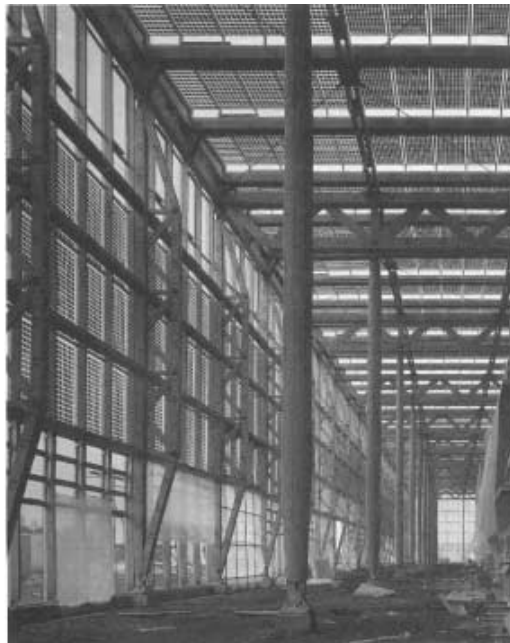
Figura 19 – Cantiere dell'Involucro, si noti la Copertura in Fotovoltaico
