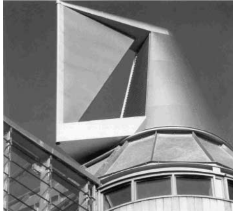
Figura 6 – Particolare del Torrino di Estrazione, Jubilee Campus in Nottingham, Arch. Hopkins e Ove Arup
